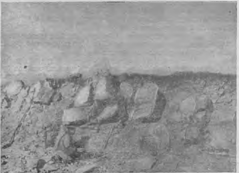
Рис. 2. Уступ, разбитый трещинами, с ясно выраженными естественными отдельностями
