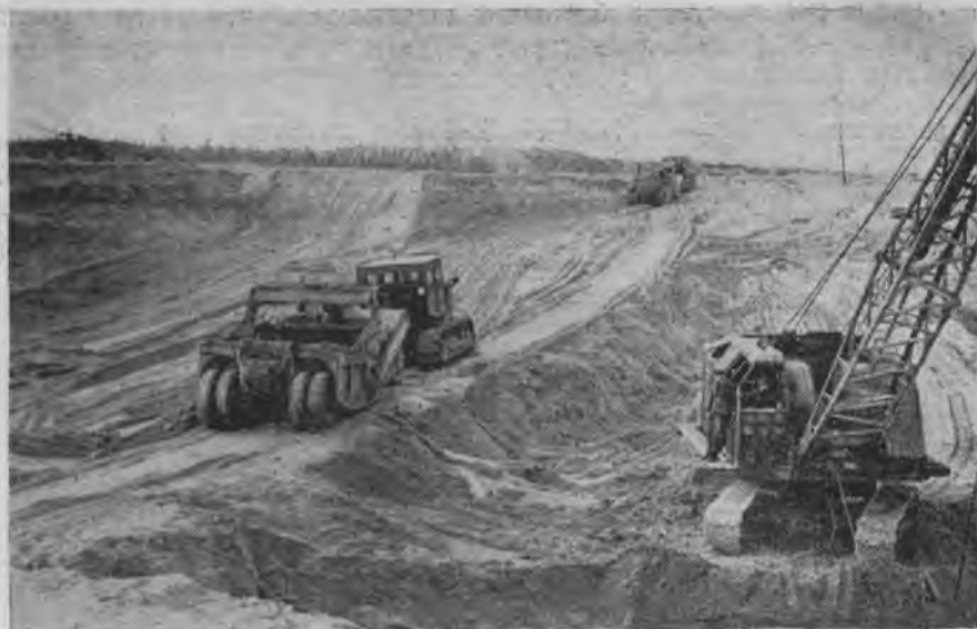
Рис. 3. Производство вскрышных работ на россыпи тракторными скреперами Д-222
